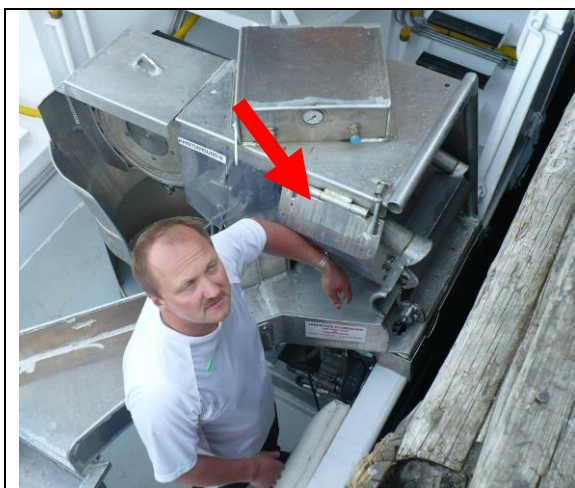
Skipper Jostein viser funksjon av nødstopppinnretning
